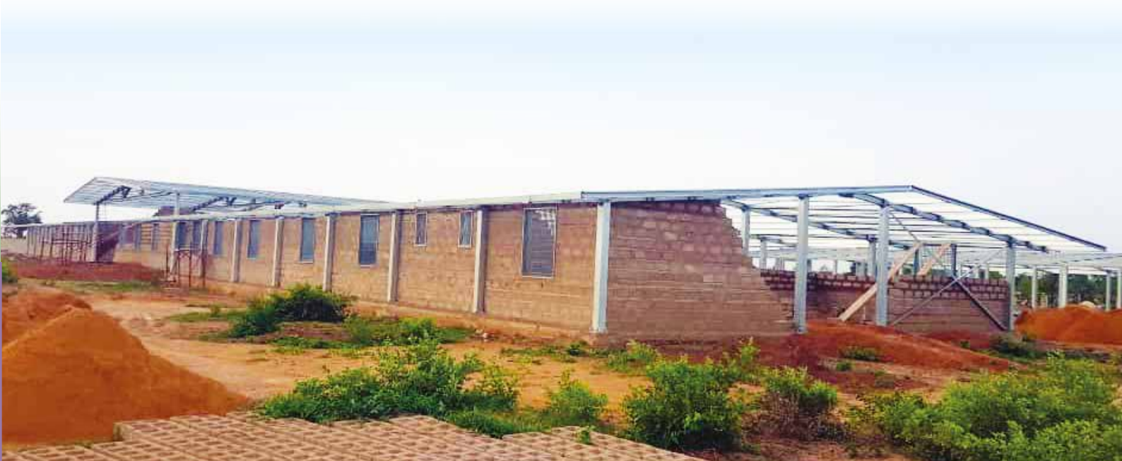
Veduta esterna dell'ospedale in costruzione con la posa, in contemporanea, dei falsi delle finestre e dei muri di tamponamento dopo aver terminato l'intera struttura in ferro.
